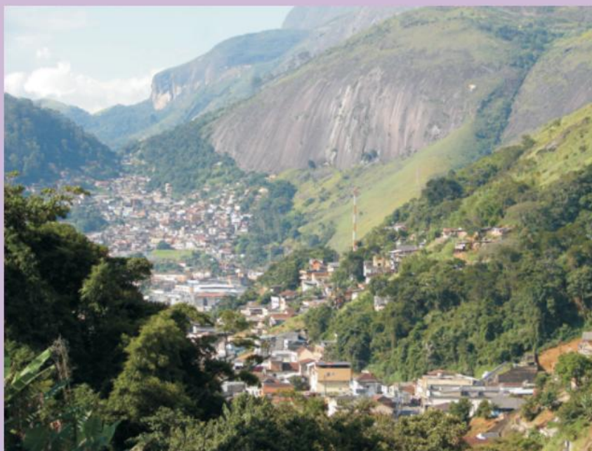
Vista panorâmica de ocupação de vale - 2º distrito
