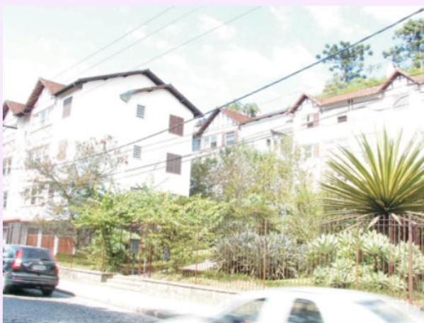
Conjunto de prédios residenciais - Avenida Tiradentes
